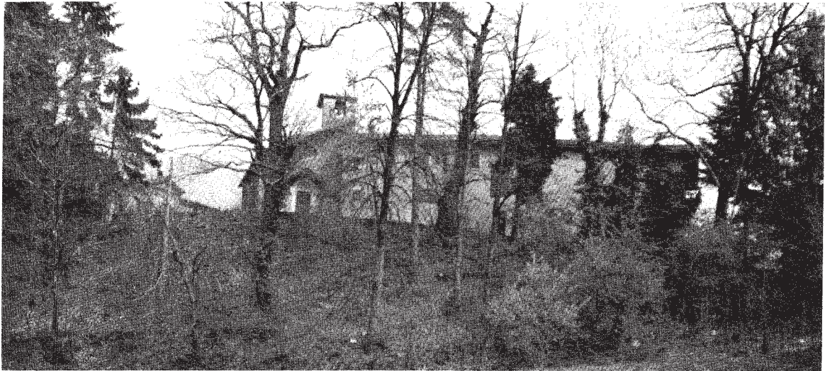
Il masserizio di San Maurizio con la storica omonima chiesetta. A sinistra s'intravede il portale del cimitero della frazione di Rovello e della cappella privata Muraini. Il complesso è oggi in territorio di Lugano.
